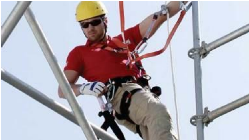
Figura 8: Utilização dos equipamentos de segurança.
