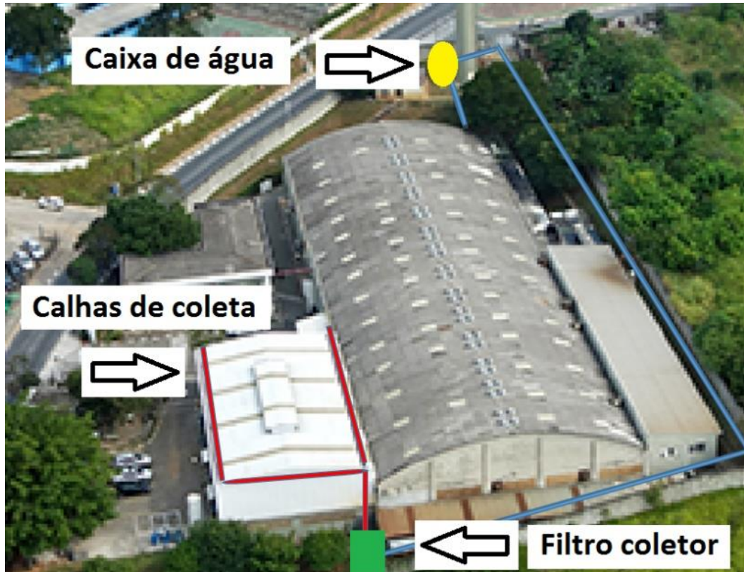
Figura 2: Apresentação da área destinada ao projeto de captação da água da chuva.
