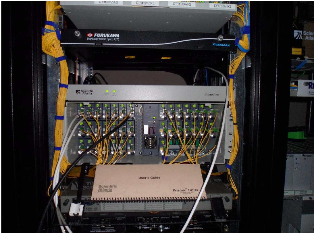
Figura 20 – Receptor Óptico no *Headend*
