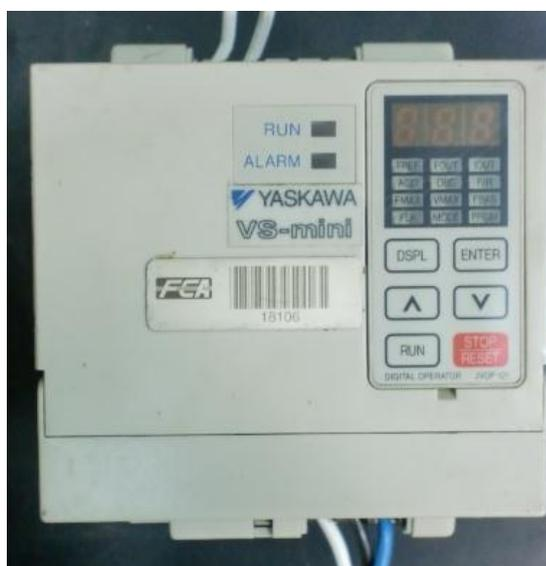
Figura 192: Inversor de frequência.
