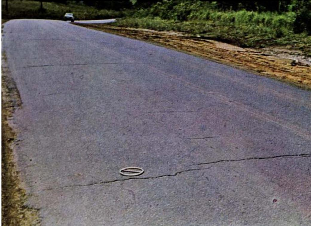
Figura 23: Trinca isolada do tipo transversal.
