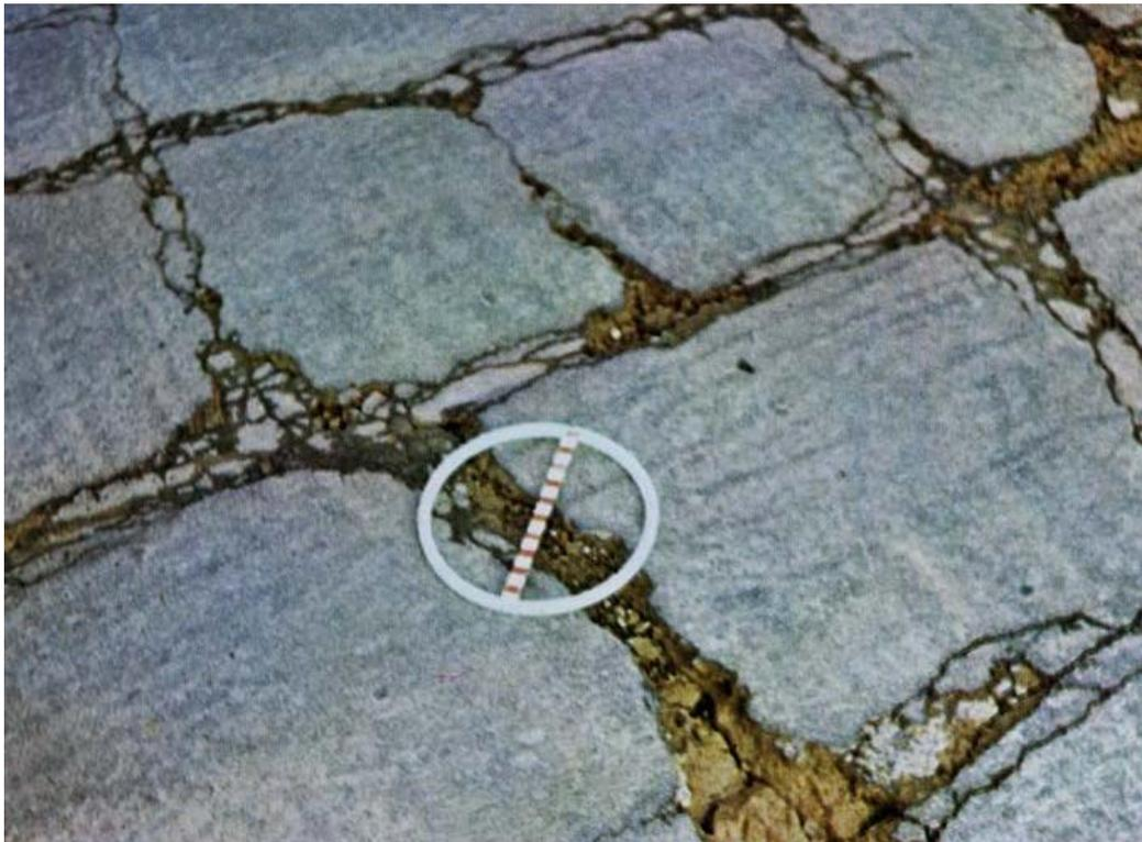
Figura 26: Trinca interligada do tipo bloco.
