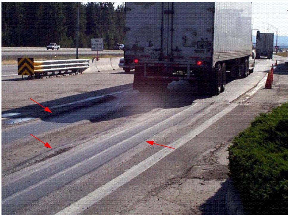
Figura 21: Exemplo real de deformação permanente.
