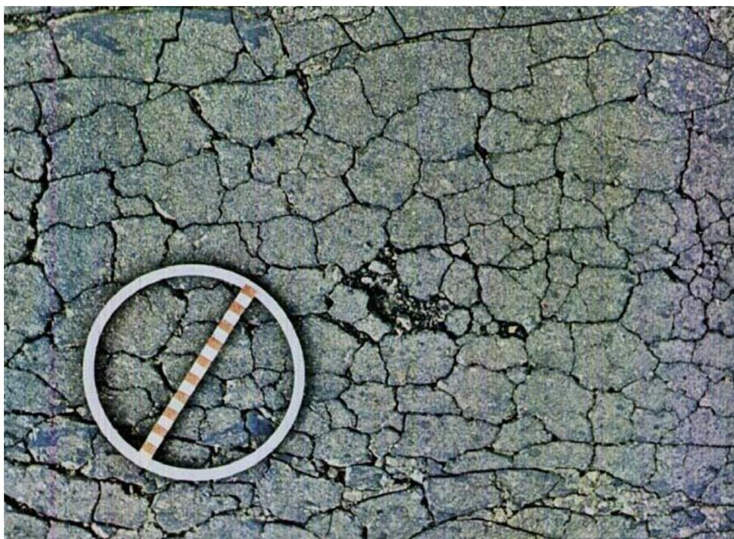
Figura 25: Trinca interligada do tipo couro de jacaré.
