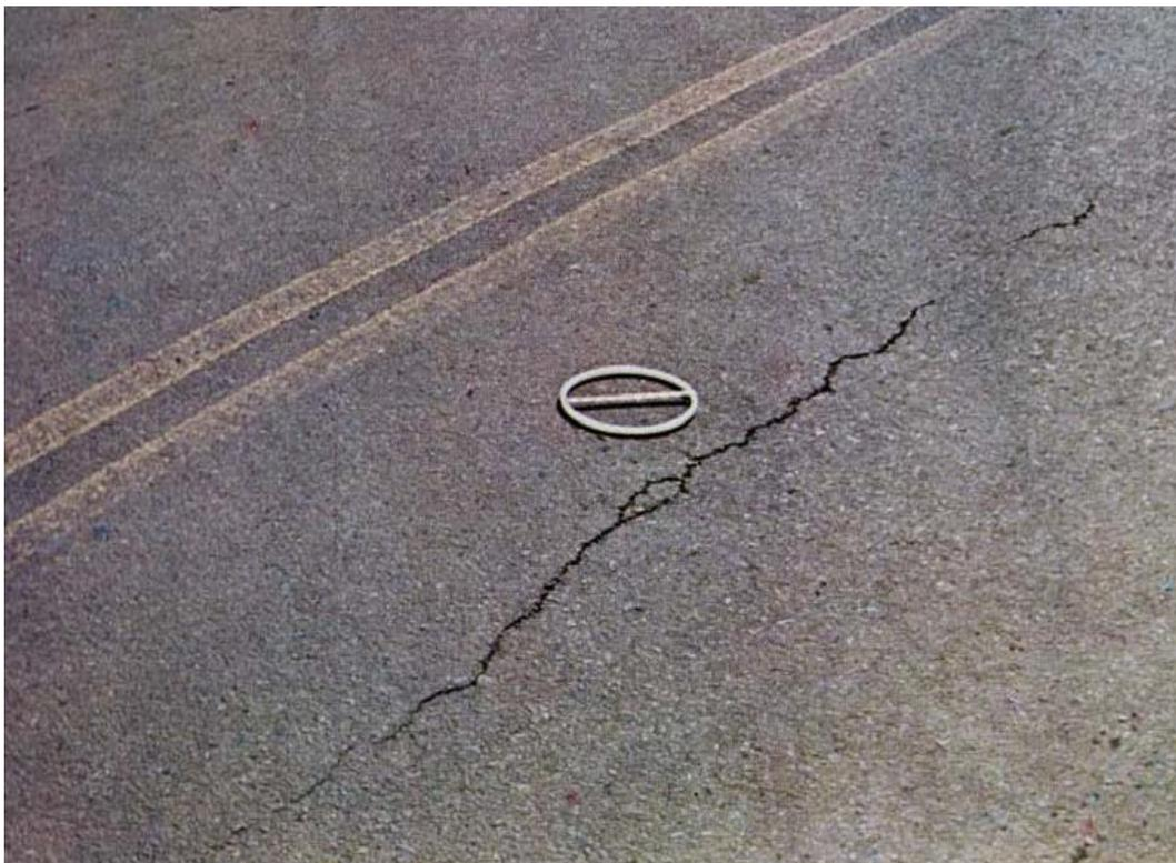
Figura 24: Trinca isolada do tipo longitudinal.
