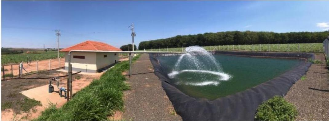
**Conjunto do Sistema de Irrigação:** Poço Artesiano, Reservatório de 1.300 m<sup>3</sup>, Casa de Bombas e Rede Elétrica.
