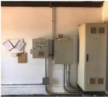
Painéis elétricos responsáveis pelo acionamento dos sistemas de bombas: bomba poço artesiano, bombas de recalque para o sistema de irrigação.
